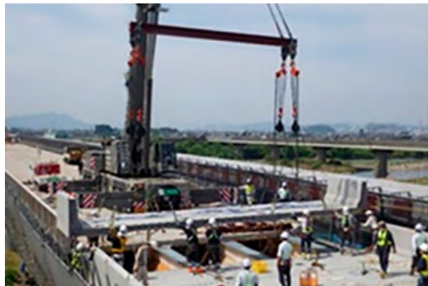
高速道路の床版取替え工事
