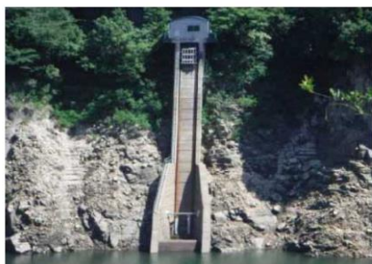
日野川第一発電所（写真は鳥取県公式サイトより）
