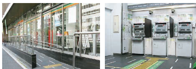
スロープや点字誘導ブロックなどの設置例(東京・芝店)
