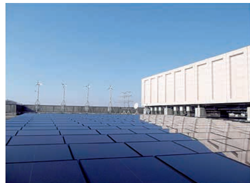
太陽光や風力を利用した発電装置 (東日本貯金事務計算センター)
