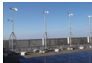
太陽光や風力を利用した発電装置 (東日本貯金事務計算センター)
