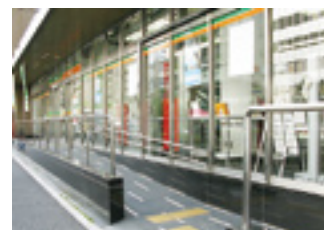
スロープや点字誘導ブロックなどの設置例(芝店)
